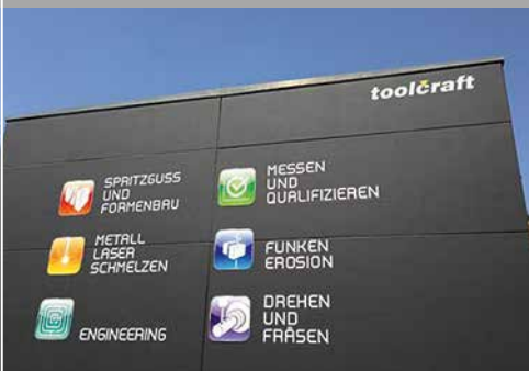
Neue Fassade in Spalt
