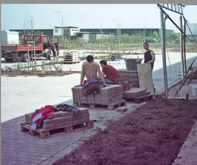
2001 Baubeginn eigenes Gebäude für unicom
